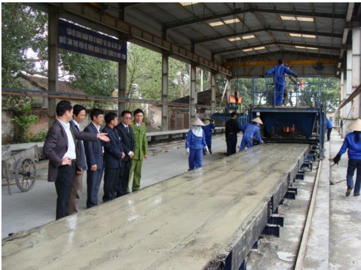
* Hình ảnh SX Tà vệt bê tông dự ứng lực tại XN VLXL cổ Loa Đông Anh:
