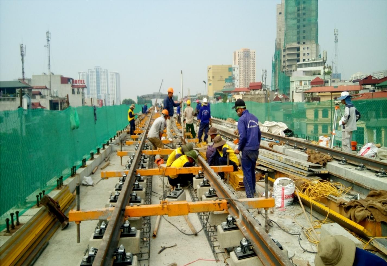
* Hình ảnh thi công công trình đường sắt trên cao Cát Linh – Hà Đông 2016:
