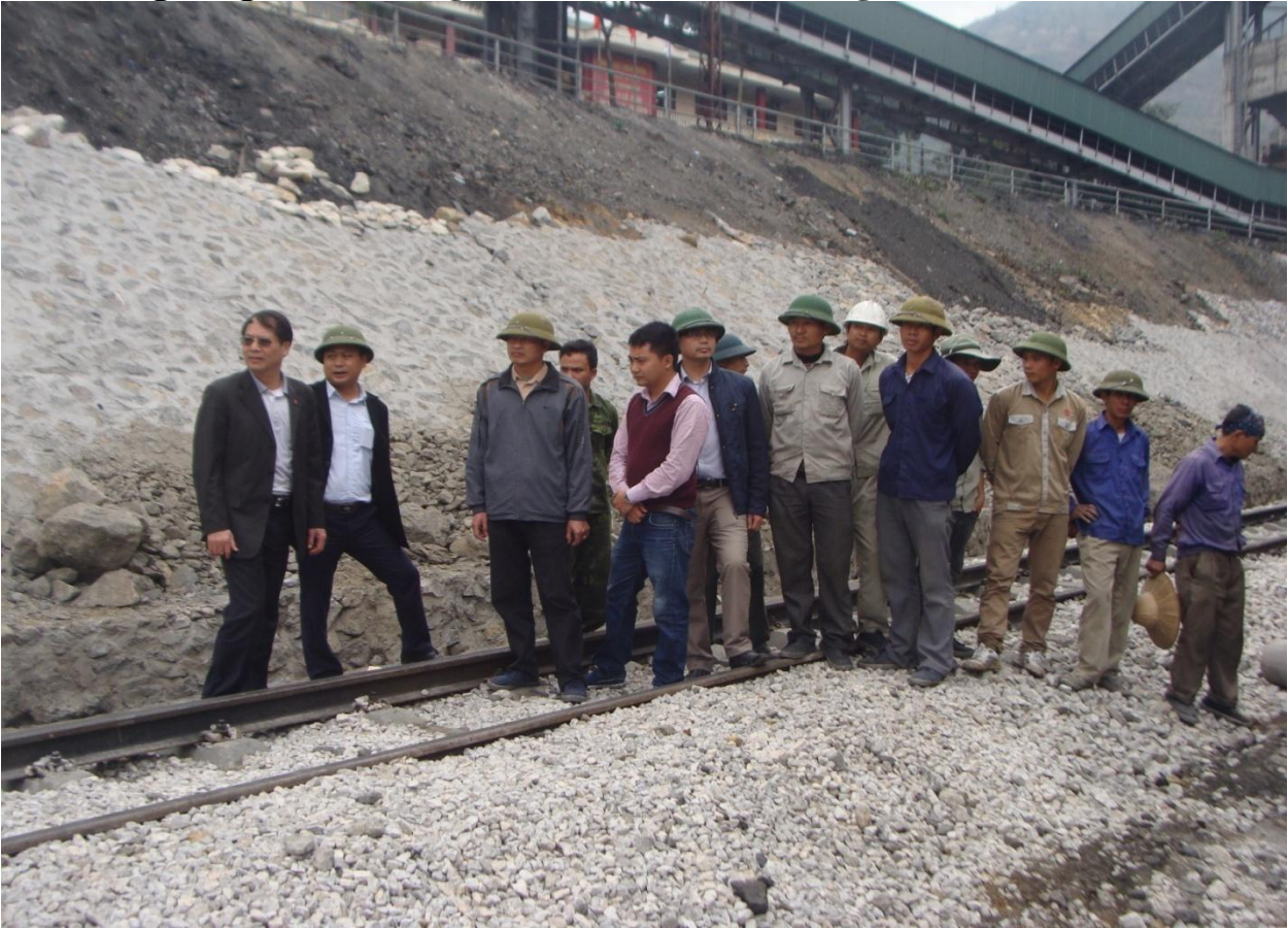
* Thi công công trình đường sắt vào mỏ Than Quảng Ninh 2016:
