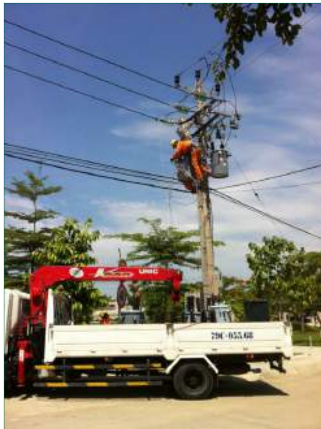
Cải tạo điện lưới nông thôn lên 22kv
