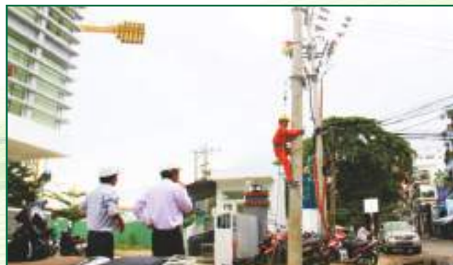
Kiểm tra thi tuyển công nhân - Phần thực hành lắp xà
