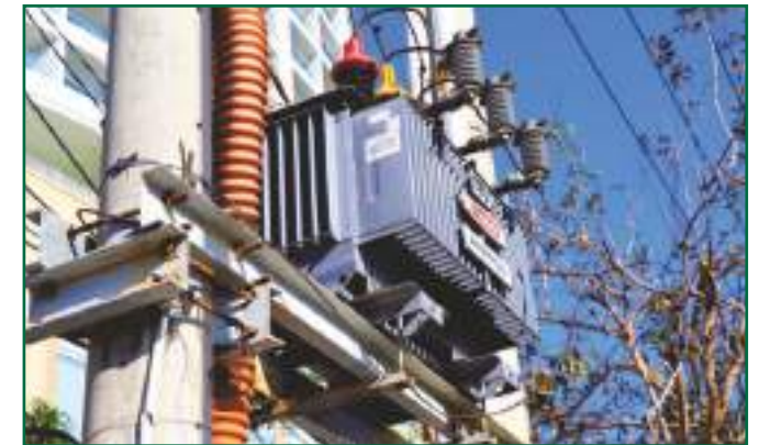
Lắp đặt máy biến áp Amorphous - Đầu tư hiệu quả và bảo vệ môi trường
