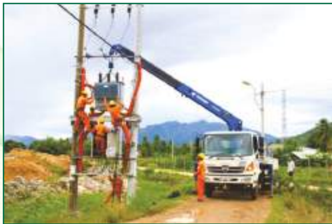
Thi công xây dựng mới Trạm biến áp 46G Vĩnh Hiệp
