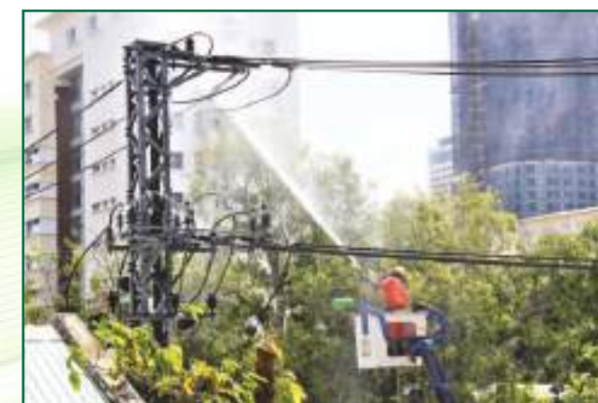
Vệ sinh hotline sứ cách điện
