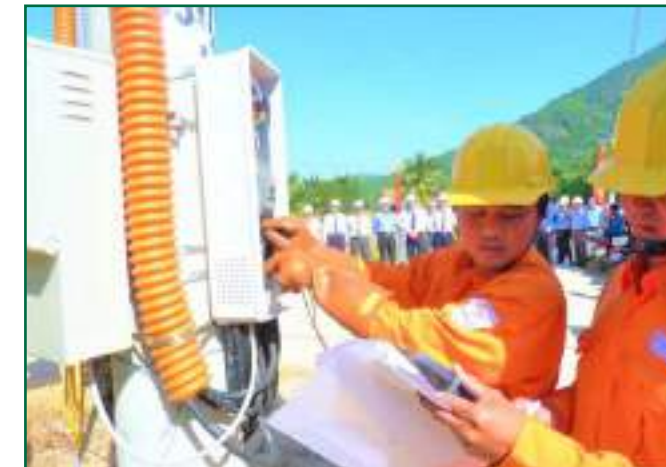
Kiểm tra thông số kỹ thuật trước khi đóng điện
