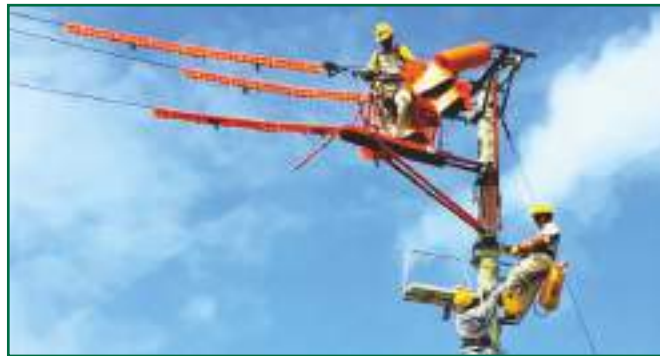
Áp dụng phương pháp bệ đỡ Platform vào sửa chữa hotline
