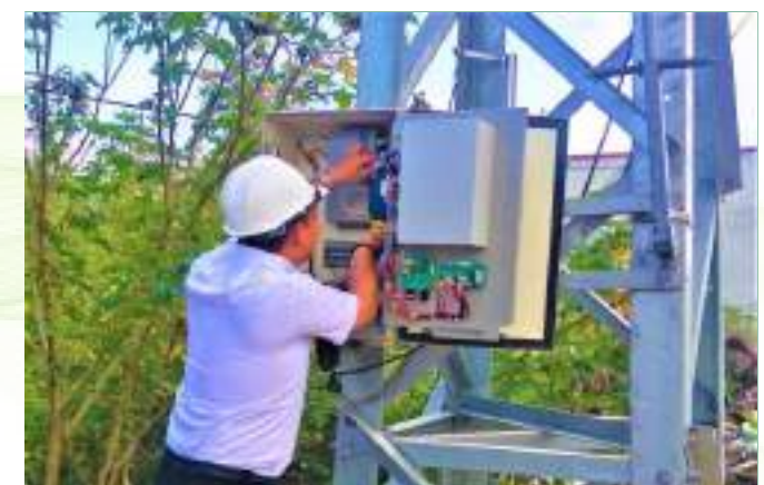
Lắp đặt thiết bị Router 3G
