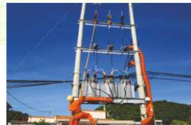
Hoàn thành công trình cấp điện cho thôn đảo Bình Hưng
