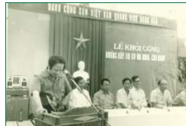
Lãnh đạo Bộ Năng lượng tại lễ khởi công DZ 110kv Nha Trang - Cam Ranh
