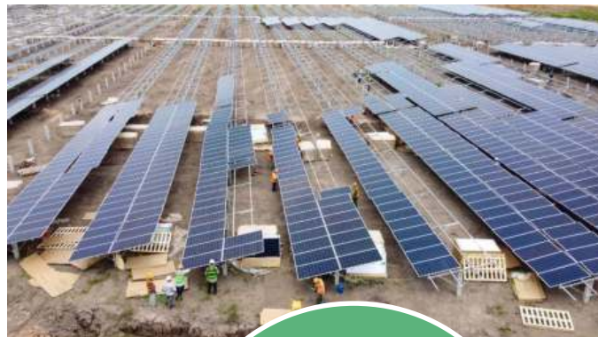
Điện mặt trời Solar Park 3
