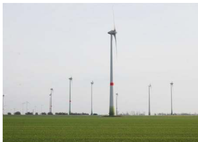
Điện gió Trung Nam
