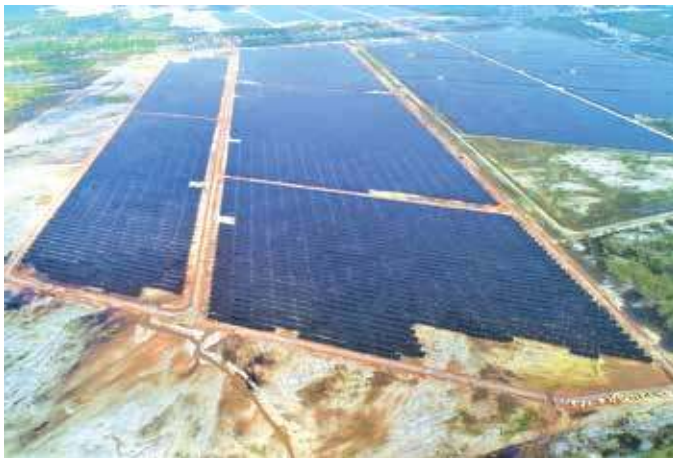
Điện mặt trời Gio Thành 1 (50MWp) - EPC
