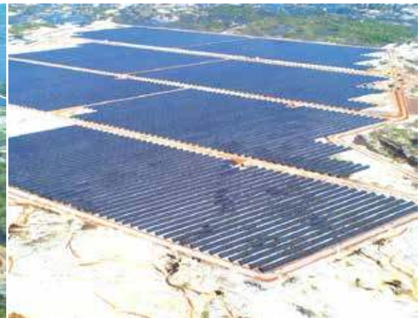
Điện mặt trời Gio Thành 2 (50MWp) - EPC
