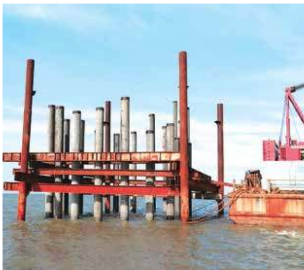
Thi công trụ điện gió Tân Thuận
