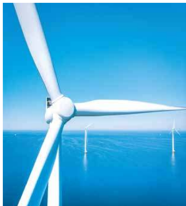
Mô tả Điện gió Tân Thuận
