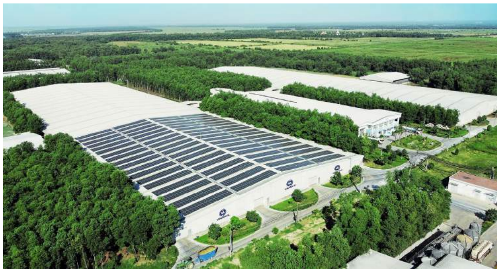
Hệ thống pin năng lượng mặt trời được lắp đặt trên mái nhà sản xuất của trang trại
