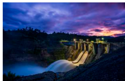
Nhà máy Thủy điện Hòa Na (Nghệ An)
