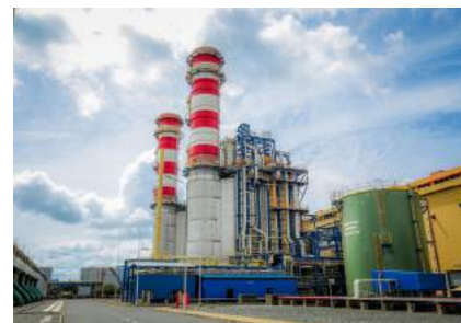
Nhà máy điện Cà Mau 2 (Cà Mau)
