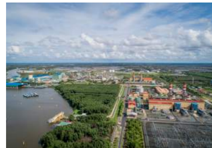
Nhà máy điện Cà Mau 1 (Cà Mau)
