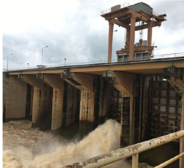
Nhà máy thủy điện Srok Phu Miêng
