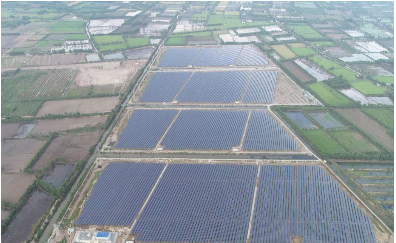
Nhà máy điện mặt trời Europlast Long An tại xã Mỹ Thạnh Bắc, huyện Đức Huệ, tỉnh Long An
