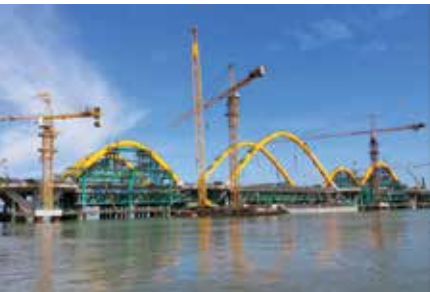
Cầu Cửa Lục, Hạ Long, Quảng Ninh
