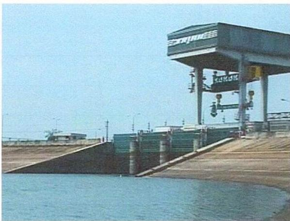
**Thủy điện Trị An – Đồng Nai :** Thi công toàn bộ tuyến áp lực và  $\frac{1}{2}$  cửa nhận nước (1984-1987). Đập chính là đập đất đá hỗn hợp có chiều dài 420m, đập tràn là đập bê tông trọng lực, chiều dài 150m với 8 khoang tràn x 15m. Nhiệm vụ chính của công trình là phát điện công suất lắp máy 400MW, điện lượng trung bình hàng năm 1,7 tỷ KWH, cải thiện lưu lượng nước sông Đồng Nai vào mùa khô.
