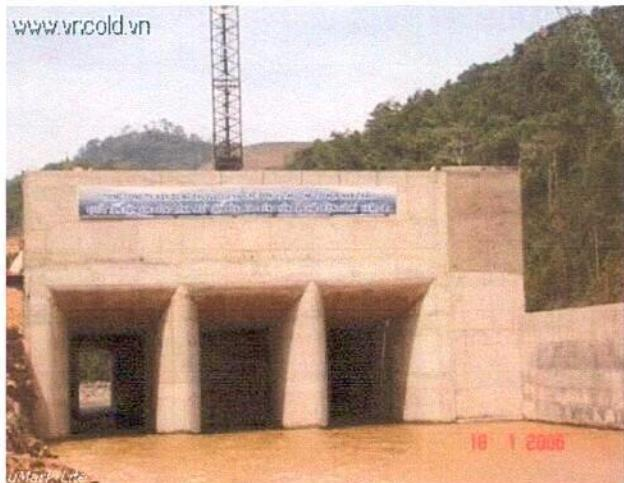
**Thủy điện Đồng Nai 3 – Đăk Nông :** Tổng thầu xây lắp, trực tiếp thi công đập chính và tràn xả lũ (2006-2010). Nhiệm vụ chính của công trình phát điện với công suất lắp máy là 180MW và điện lượng trung bình hàng năm là 607,1 triệu KWH. Đập chính là đập bê tông đầm lăn (RCC), dài 640m. Khối lượng bê tông đập chính và tràn là 1.147.000m<sup>3</sup>.
