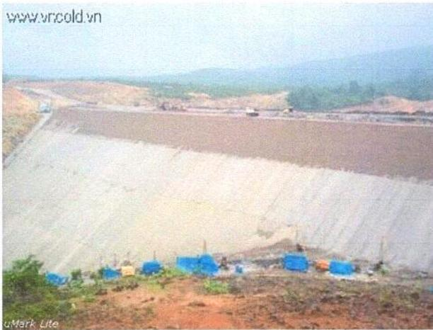
**Thủy điện Quảng Trị :** Tổng thầu xây lắp, trực tiếp thi công đập chính và tràn xả lũ (2003-2007). Nhiệm vụ chính của công trình là điều tiết nước phục vụ tưới 12.281ha lúa, 1.600ha hoa màu, cấp nước sinh hoạt cho hạ lưu, giảm lũ cho hạ lưu và phát điện với công suất lắp máy 70MW, điện lượng trung bình hàng năm 260,52 triệu KWH. Đập chính là đập đá đỗ bản mặt bê tông cốt thép lần đầu xây dựng tại Việt Nam.
